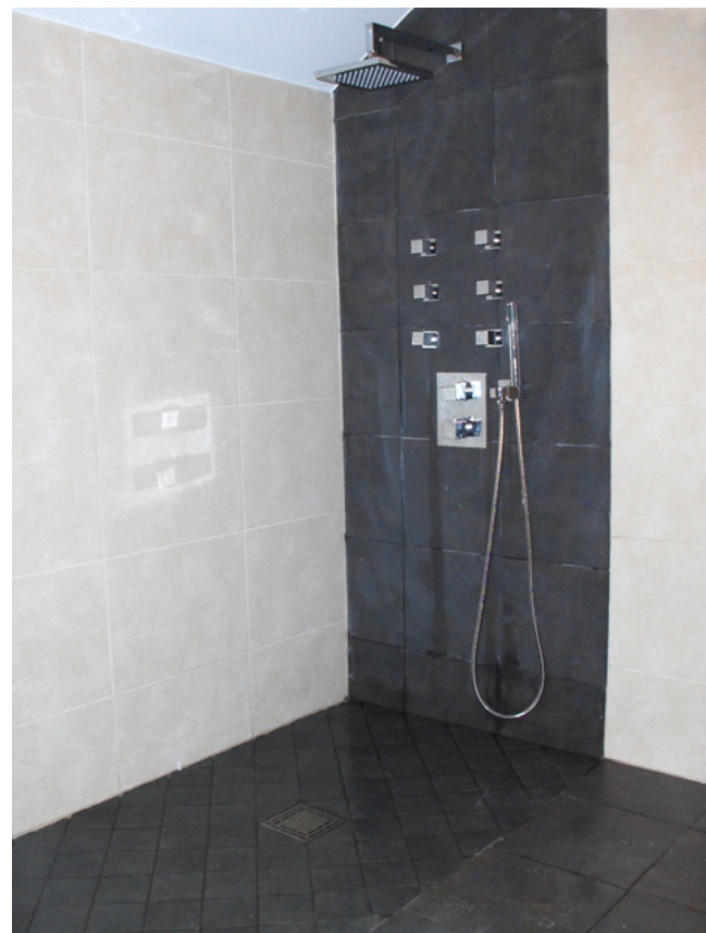
Instalación Columnaspacio terminada
